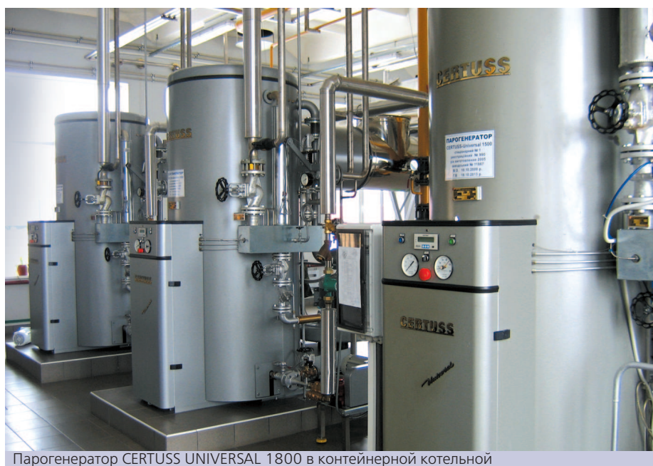
Парогенератор CERTUSS UNIVERSAL 1800 в контейнерной котельной
